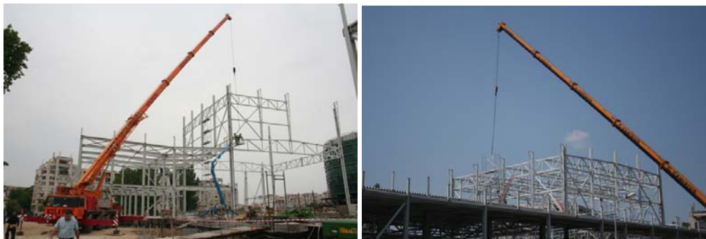
Figura 9. Structura scenei în faza de montaj
