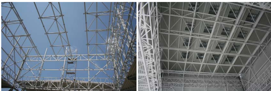
Figura 5. Vederea structurii metalice a turnului în faza de montaj
