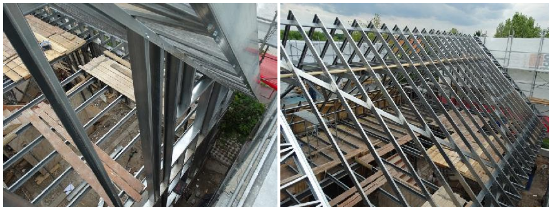
Figura 7: Structura casei analizate în stadiu de execuție
