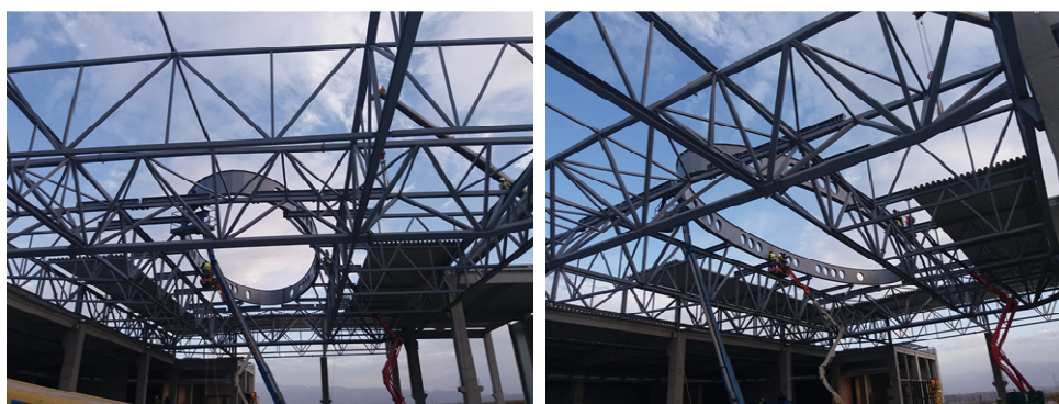
Figura 15 – Poze de pe parcursul montajului (etapa V)
